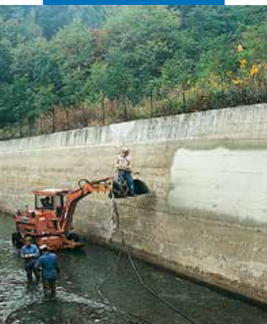
Nanašanje Planiseal-a 88 z brizganjem na stene vodnega kanala hidroelektrarne
