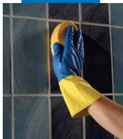
Zaključna obdelava in čiščenje z Mapei celulozno gobo
