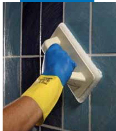
Čiščenje in odstranjevanje odvečne fugirne mase z vodo in namenskim filcem Scotch-Brite®
